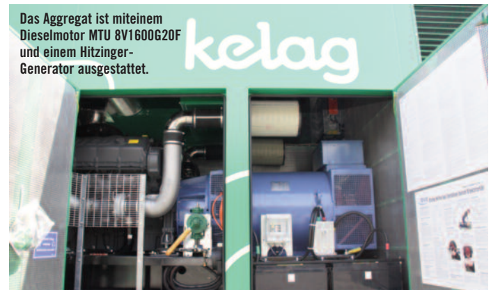
„Innenleben“ der Aggregat-Schaltanlage. Sie ist für Inselfähigkeit und Netzparallelbetrieb ausgelegt.
